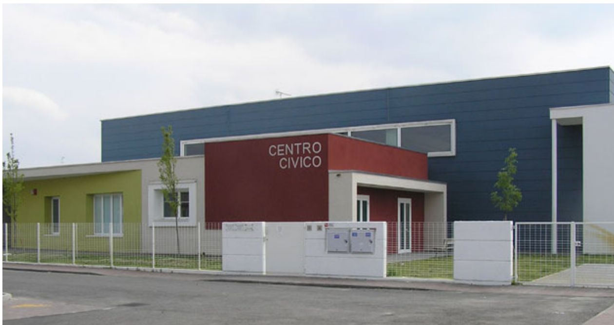
Fig. 2 - Vista frontale della scuola di Mortizzuolo di Mirandola.
