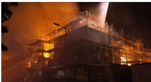
Fig. 8 - Incendio su un edificio in legno in fase di costruzione (sx) e su un edificio adiacente ad un edificio in legno andato in fiamme (dx) - fonte delle immagini: bbc.co.uk .
