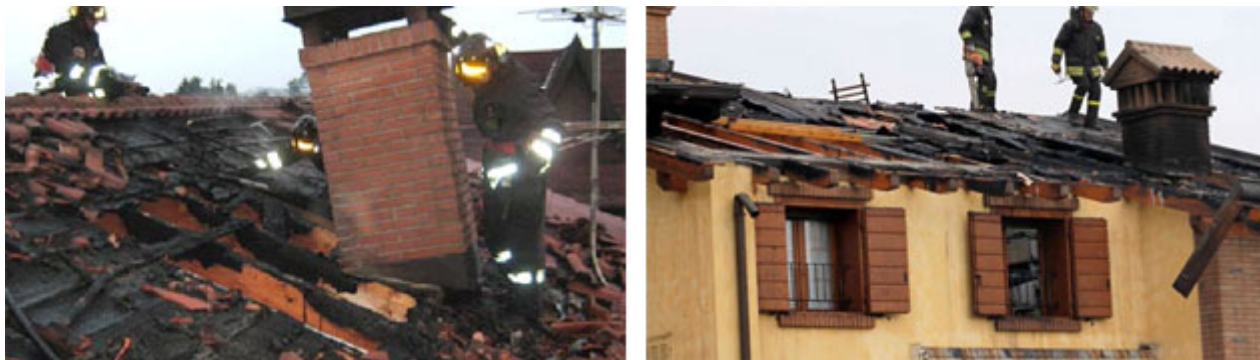
Fig. 1 - Incendio su edificio residenziale in provincia di Varese (sx - fonte: varesenews.it ) e Reggio Emilia (dx - fonte: reggionline.com ).
