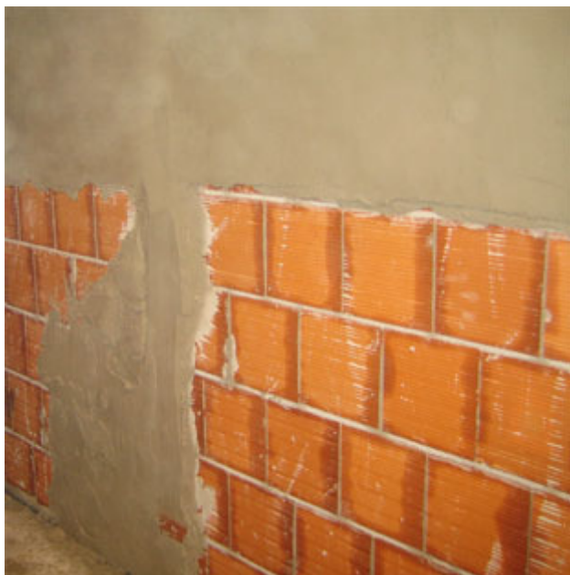
Fig. 12 - Semplicità di posa in opera delle murature POROTON®: fase di intonacatura della parete.
