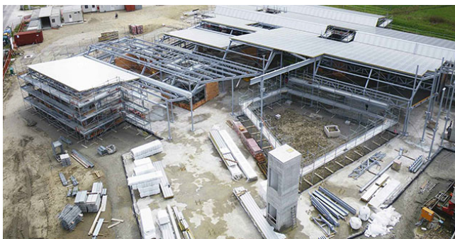
Fig. 4 - Vista generale di fasi realizzative di cantiere.
