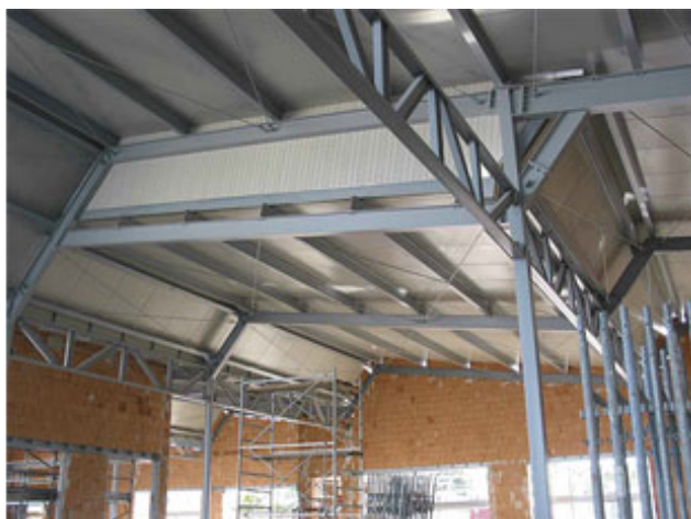
Fig. 5 - Dettagli dello scheletro portante in acciaio senza elementi di chiusura e con tamponamento in laterizio e pannelli di copertura
