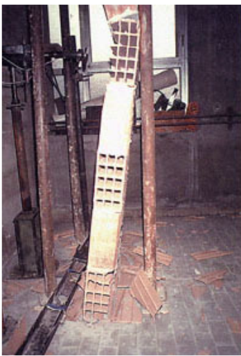
Fig. 2 - Pannello tipo -4- dopo il collasso (vista laterale).
