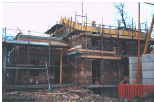
Fig. 6 – Il fabbricato in costruzione.
