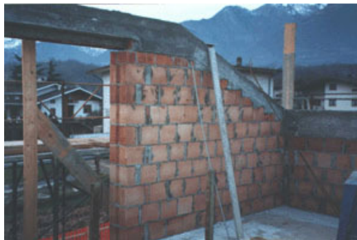
Fig. 8 – Particolare del cordolo in c.a. a livello della copertura.
