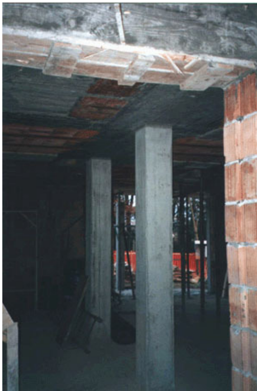
Fig. 7 – Particolare dei pilastri interni in c.a.
