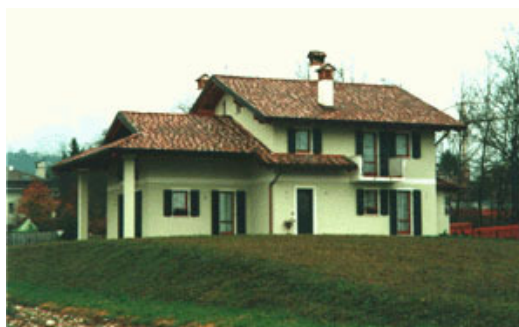
Fig. 9 – Il fabbricato finito.
