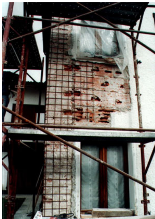
Fig. 2 - L'ancoraggio della rete elettrosaldata.
