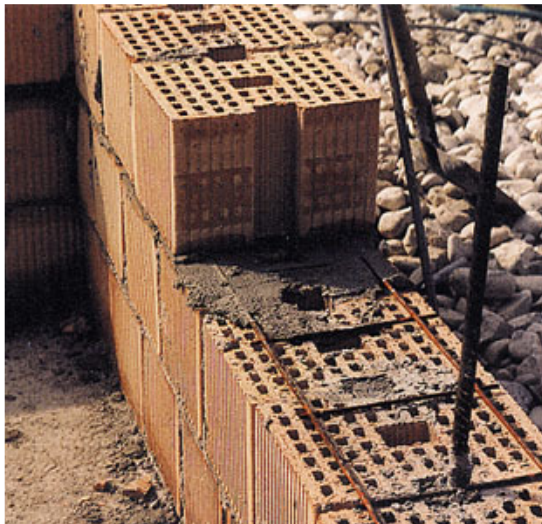
Fig. 1 - Muratura armata POROTON®.
