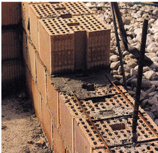
Fig. 1 - Muratura armata POROTON®.
