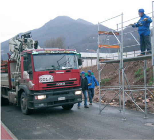
Fig. 6 - Fase di scarico in sicurezza del materiale di approvvigionamento.
