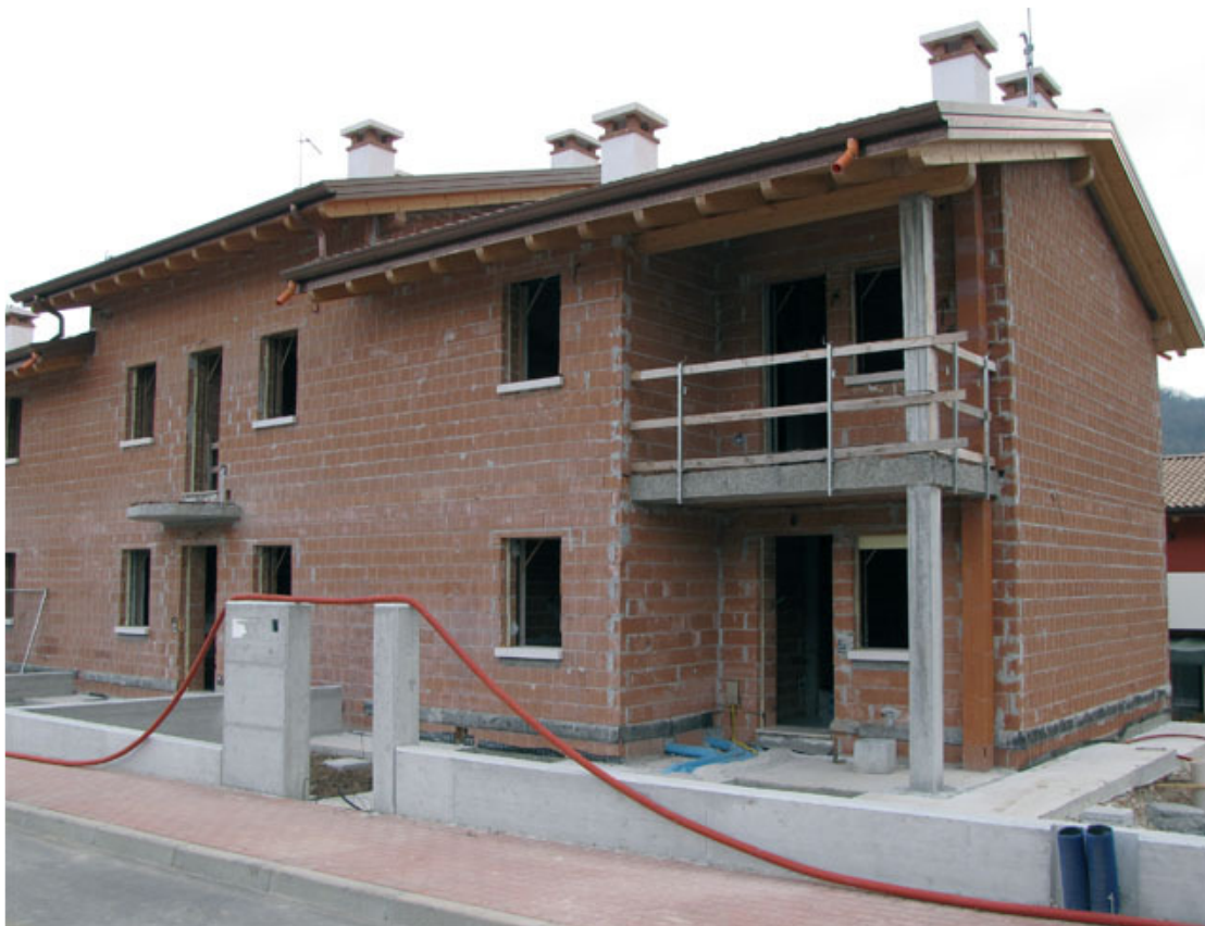
Fig. 7 - Edificio al grezzo.
