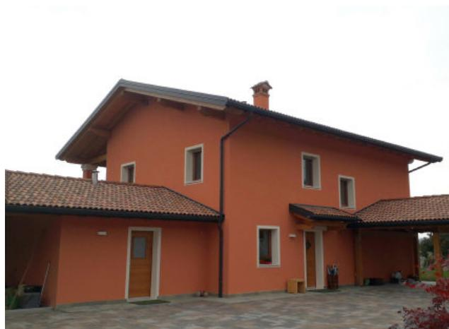
La struttura muraria è rivestita esternamente con cappotto termico in lana di roccia da 15 cm di spessore; la copertura in legno è del tipo ventilato e coibentata con un doppio strato incrociato in lana di roccia da 10+10 cm.
