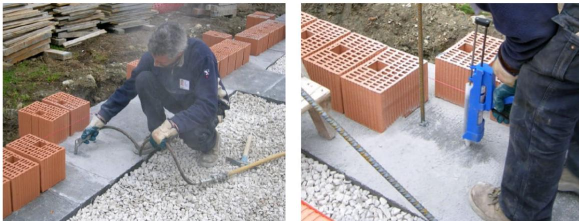
Fig. 9 – Post-installazione delle barre nella fondazione a getto avvenuto: pulizia dei fori realizzati (sx) e installazione delle barre con resina (dx) per la realizzazione della muratura armata POROTON® Brite sp. 30 cm (© Nicola Canal).
