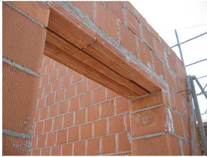
Fig. 11 – Esempio di architrave soprafinestra in una struttura in muratura armata.
