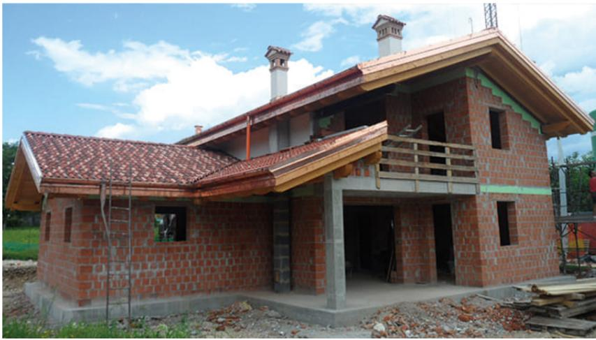
**Muratura armata progettata in zona ad alta sismicità con analisi non lineare.**
