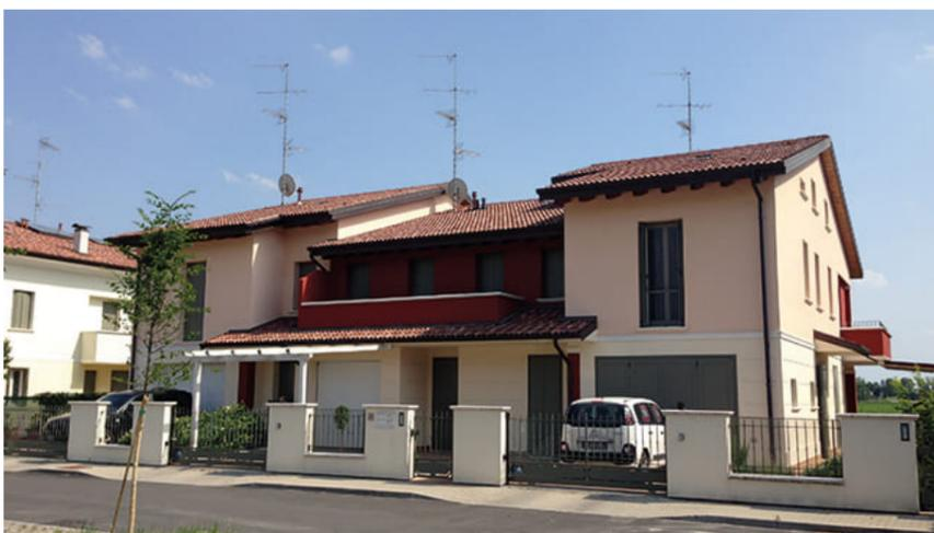
**Struttura mista (muratura armata e telaio in c.a. collaboranti) ha superato indenne la sequenza sismica Emilia 2012.**
