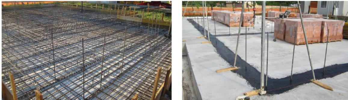
Fig. 8 – Installazione delle barre di ripresa prima del getto di fondazione (sx) e le riprese pronte per la realizzazione della muratura armata POROTON® Brite sp. 30 cm (dx) (© Flavio Mosele).
