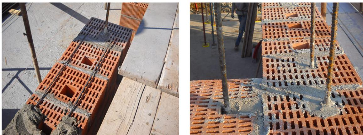
Fig. 1 – Muratura armata in blocchi POROTON<sup>®</sup> P800 MA Brite confezionata con giunti di malta realizzati a regola d'arte, armatura orizzontale disposta nel letto di malta e armatura verticale negli appositi vani dei blocchi riempiti di malta (tratta da "Le costruzioni di muratura nelle NTC 2018" Murature Oggi 128).
