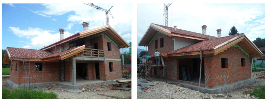
Fig. 1 – Vista ovest e nord del fabbricato al grezzo.
