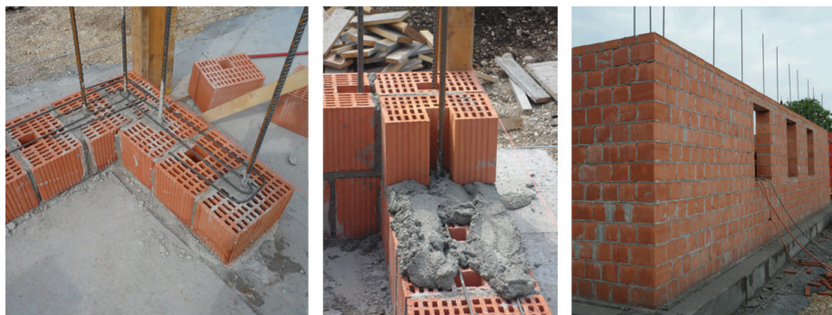
Fig. 3 – Fasi di realizzazione della muratura armata POROTON®: primi corsi di blocchi con armatura verticale “inghisata” nella fondazione ed armatura orizzontale predisposta nel giunto orizzontale. A destra la prima elevazione conclusa, pronta per la realizzazione del cordolo e solaio (si notino i ferri di chiamata per le murature armate del piano primo).
