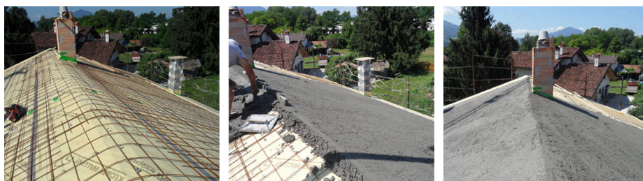
Fig. 5 – Fasi di realizzazione della cappa in cls alleggerito armata sulla copertura in legno.
