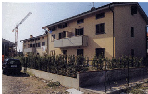
Fig. 9 - Vista del fabbricato al termine dei lavori di costruzione.
