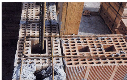
Fig. 4 - Particolare dell'incrocio a "T" tra setti murari.
