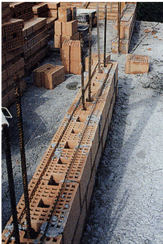
Fig. 6 - Disposizione delle staffe orizzontali; sono visibili le barre verticali di armatura ancorate nella fondazione sottostante.
