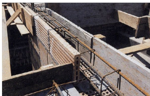
Fig. 5 - Particolare del cordolo di solaio.
