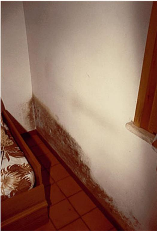
Foto 6 – Condensa in corrispondenza del nodo parete-solaio.
