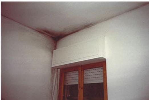
Foto 1 – Esempio di condensa superficiale causata dalla presenza di un ponte termico.
