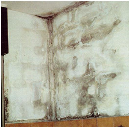
Foto 4 - Pareti completamente intaccate dall'umidità accentuata dalla probabile presenza di acqua interstiziale nelle murature.
