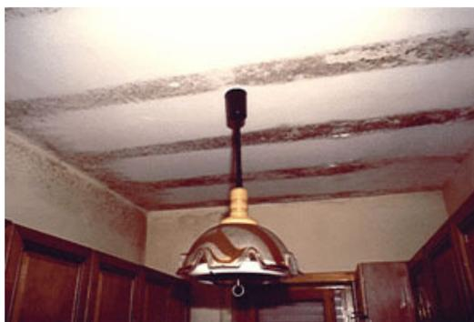
Foto 3 - Condensa superficiale con termoforesi in corrispondenza dei travetti del solaio.
