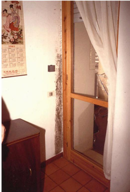
Foto 7 – Muffe da condensa superficiale in corrispondenza del nodo muro-serramento.
