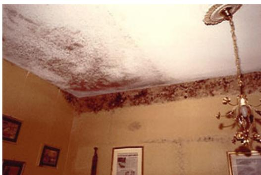
Foto 2 - Formazione di muffe diffusa, particolarmente marcate in corrispondenza di una trave in c.a..
