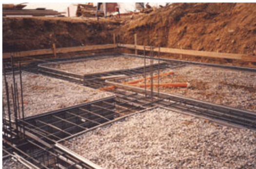
Fig. 1 - Le fondazioni a trave continua sono state realizzate impiegando il pannello FlashFond®.
