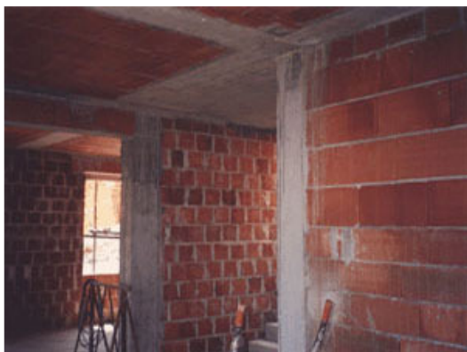
Fig. 8 - Vista dell'interno del fabbricato in fase di realizzazione.
