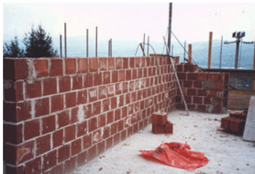
Fig. 2 - Pareti in muratura armata POROTON® in fase di costruzione.
