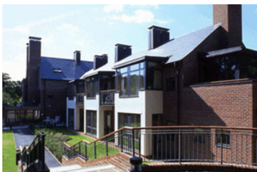
Fig. 2 - Il laterizio è, assieme al legno, uno dei materiali più bioecocompatibili, in quanto realizzato con materiali naturali, estremamente durevole e riciclabile ed estremamente adatto anche negli interventi di recupero di edifici storici. L'immagine si riferisce ad una residenza per anziani riservata agli attori a Denville Hall, in Inghilterra, costruita nel XIX secolo e recuperata nel 2000 dallo studio inglese Lawrence and Wrigthson con gli stessi laterizi utilizzati nell'edificio originario, oltre ad altri materiali bioecocompatibili, quali calce, legno, ardesia e rame.
