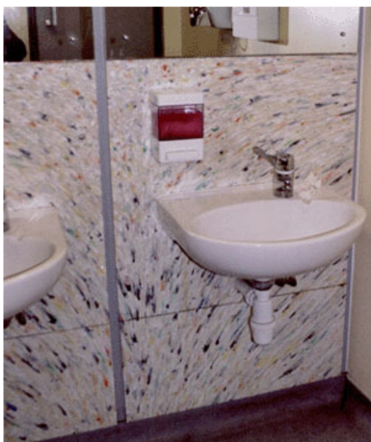
Fig. 4 - Un esempio di un prodotto per rivestimento completamente riciclato, chiamato Origins , che proviene dal riciclo di bottiglie colorate di detersivo ed è stato applicato nei bagni del famoso supermercato Sainsbury's nel nuovo quartiere Greenwich a Londra.
