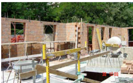
Fig. 4, 5 - Vista dei setti in muratura armata in fase di costruzione.
