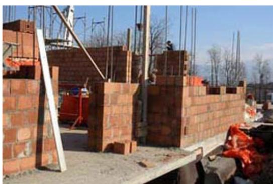
Fig. 13 - Costruzione della struttura in muratura armata: vengono disposte le barre di armatura, opportunamente giuntate, e si procede nella posa dei corsi di blocchi, provvedendo al riempimento con malta dei fori in cui alloggiavano le armature verticali.
