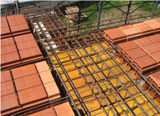
*Fig. 23 - Particolare dell'appoggio di una trave in c.a. sulla muratura perimetrale.*
