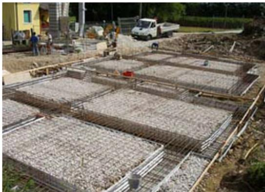
Fig. 8 - Le fondazioni, costituite come in tutti gli edifici in muratura portante da un reticolo di travi rovesce, sono state realizzate nell'intervento qui descritto utilizzando i casseri a perdere "FlashFond".
