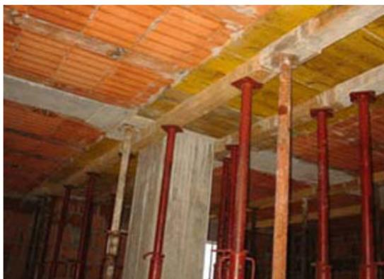
Fig. 11 - Il pilastro in c.a. all'interno della struttura muraria.
