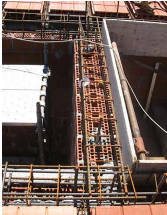
Fig. 17, 18 - I cordoli in c.a. devono essere disposti al di sopra di tutte le murature, con le caratteristiche geometriche e di armatura minima previste dal D.M. 16/1/1996.
