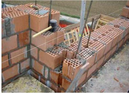
*Figg. 19, 20 - Fasi di avanzamento nella costruzione delle pareti in muratura armata.*
