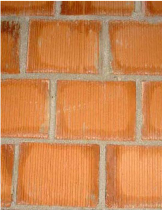
*Fig. 29 - Particolare dei giunti di malta: la malta deve essere disposta sia nei giunti orizzontali, sia in quelli verticali.*
