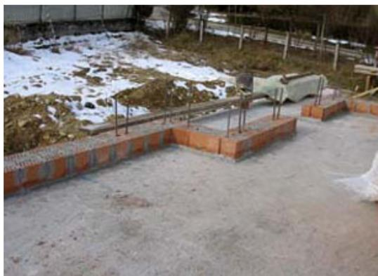
Fig. 12 - Posa del primo corso di blocchi: i blocchi possono essere preventivamente posizionati "a secco" per individuarne il corretto posizionamento in relazione alle posizioni di armatura previste, oppure per procedere all'inghisaggio dei ferri di chiamata. Successivamente si procede alla loro posa con malta.
