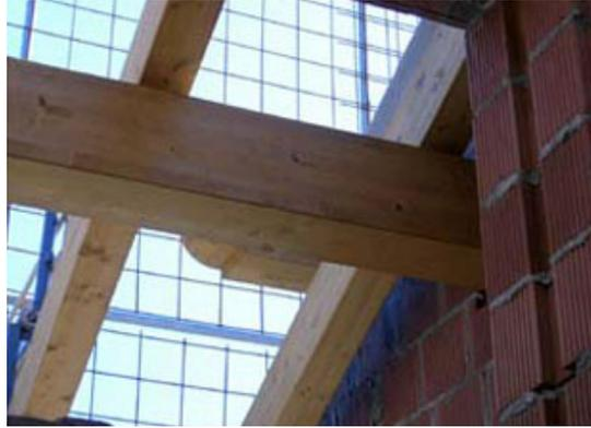
*Figg. 21, 22 - Particolari della struttura del solaio di copertura posizionata sulla muratura.*
