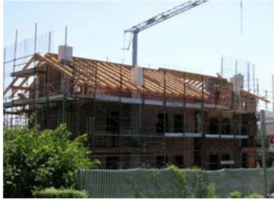
*Fig. 28 - Fasi di posa della struttura in legno della copertura.*
