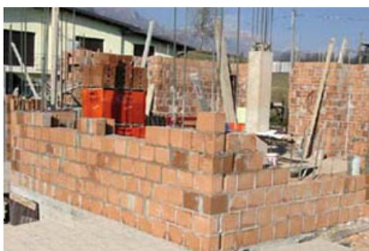
Fig. 14 - Con la muratura armata POROTON® si possono realizzare strutture in zona sismica con setti murari disposti lungo il perimetro del fabbricato e pilastri in c.a. all'interno in modo da permettere la massima libertà nella distribuzione degli spazi interni.
