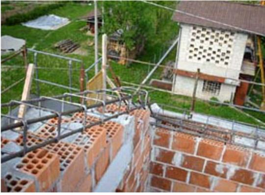
*Fig. 27 - Disposizione delle armature per i cordoli in corrispondenza delle teste delle murature al di sotto della copertura.*
