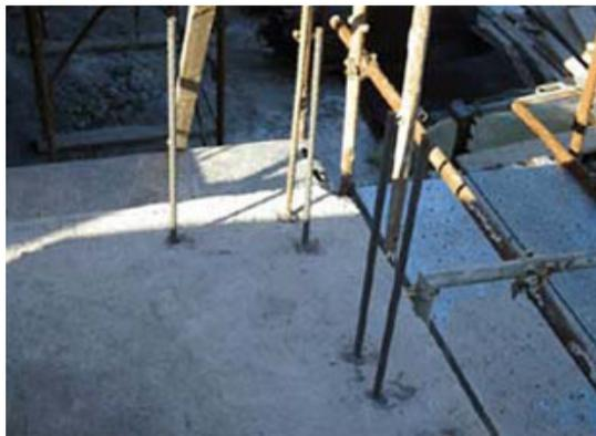
Fig. 9 - I ferri di chiamata dal piano interrato sono stati posizionati con una operazione di "inghisaggio" utilizzando apposite resine antiritiro. Questo tipo di operazione permette di posizionare le barre con la massima precisione in corrispondenza dei fori per l'alloggiamento delle armature predisposti nei blocchi POROTON®. In generale è possibile in alternativa prevedere ferri di chiamata già posizionati prima del getto delle pareti in c.a. del seminterrato.
