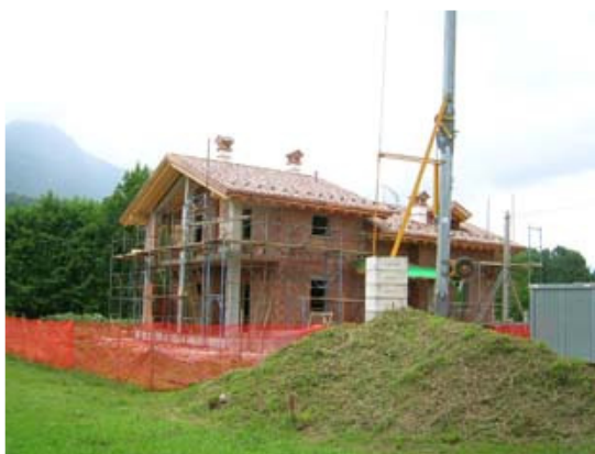
Fig. 9 - Vista dell'edificio in avanzata fase di realizzazione.
