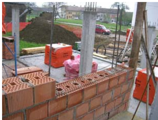
Fig. 4 - Particolare della testa di un setto murario: si notano le armature verticali all'estremità e le staffe orizzontali.
