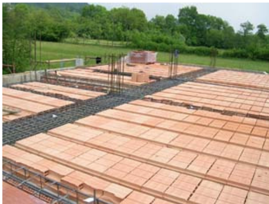
Fig. 8 - Il solaio prima del getto.
