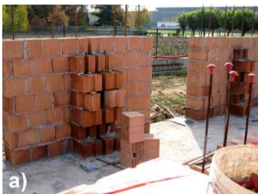
Fig. 7 - Particolare muratura armata: interno del giunto strutturale (a) ed esterno del giunto strutturale (b).
