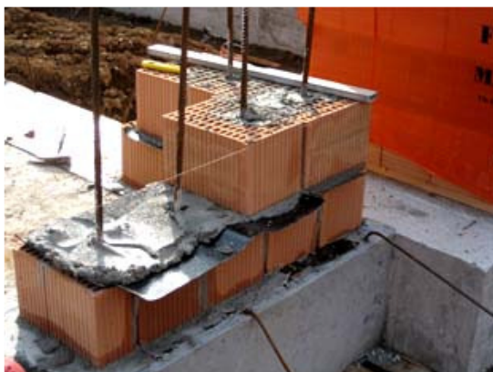
Fig. 6 - Particolare muratura armata: primo corso e guaina taglia muro.
