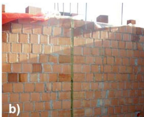
Fig. 7 - Particolare muratura armata: interno del giunto strutturale (a) ed esterno del giunto strutturale (b).
