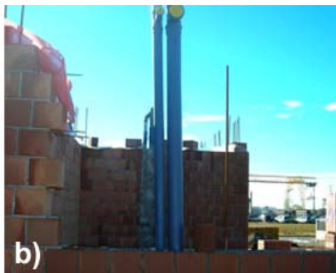
Fig. 5 - Particolare impianti: riprese da fondazioni (a) ed estensione ai piani (b).
