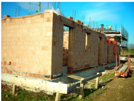
Fig. 4 - La muratura perimetrale del piano terra di un edificio bifamiliare della lottizzazione.
