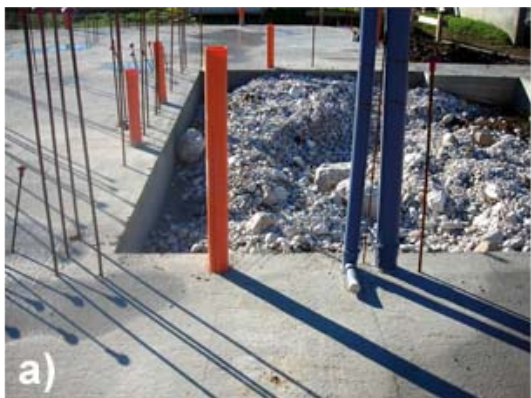
Fig. 5 - Particolare impianti: riprese da fondazioni (a) ed estensione ai piani (b).
