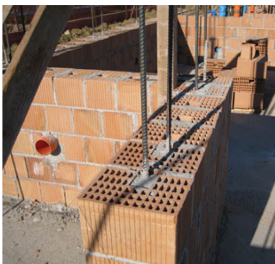
Fig. 3 - Particolare della muratura in fase di costruzione.
