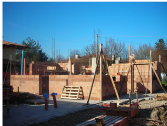
Fig. 4 - Il passaggio degli impianti viene predisposto già in fase di costruzione della muratura.
