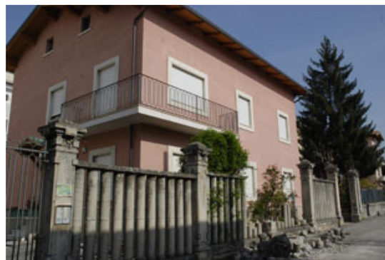
Esempio di edificio di recente costruzione realizzato in muratura portante, non danneggiato dal sisma in Abruzzo.
