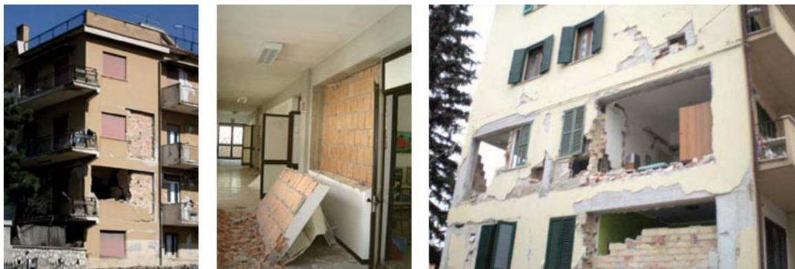
Fig. 1 – Danni alle tamponature durante le ricognizioni dopo il terremoto de L'Aquila.
