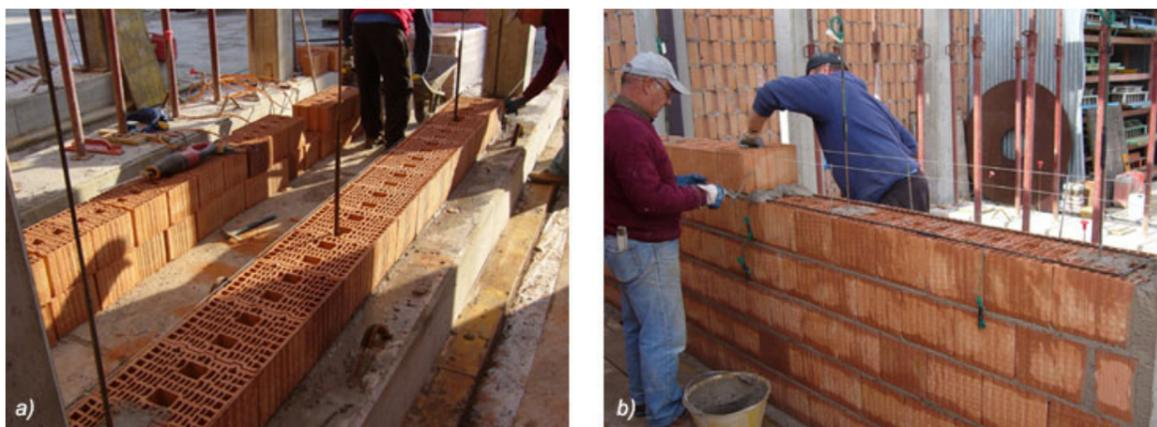
Fig. 3 – Fasi realizzative della tamponatura armata.
