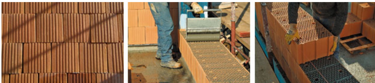
Fig. 5 - Muratura rettificata POROTON® realizzata con blocco POROTON® Plan "ad incastro", con giunto orizzontale sottile (spessore 1 mm, realizzato con rullo stendigiunto) e giunto verticale a secco con giustapposizione delle teste maschiate dei blocchi.
