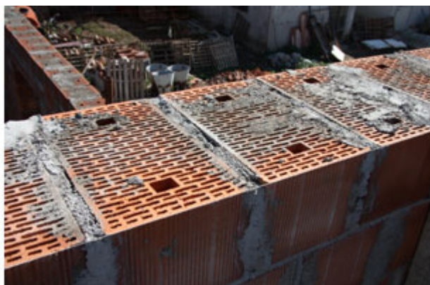
Fig. 1 - Muratura ordinaria realizzata con blocco POROTON® liscio, con giunto orizzontale e verticale riempito di malta.
