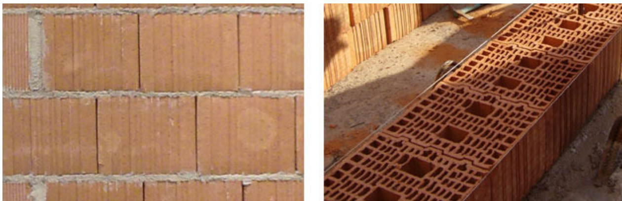
Fig. 2 - Muratura ordinaria realizzata con blocco POROTON® "ad incastro", con giunto orizzontale riempito di malta e giunto verticale a secco con giustapposizione delle teste maschiate dei blocchi.
