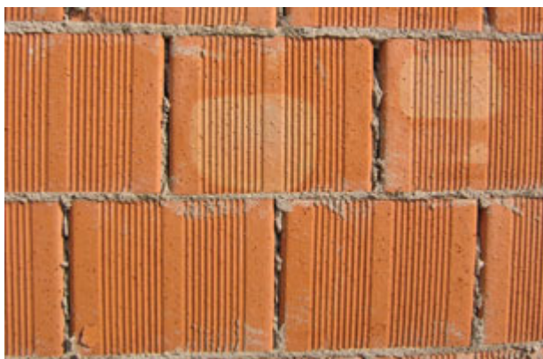
Fig. 1 - Muratura ordinaria realizzata con blocco POROTON® liscio, con giunto orizzontale e verticale riempito di malta.
