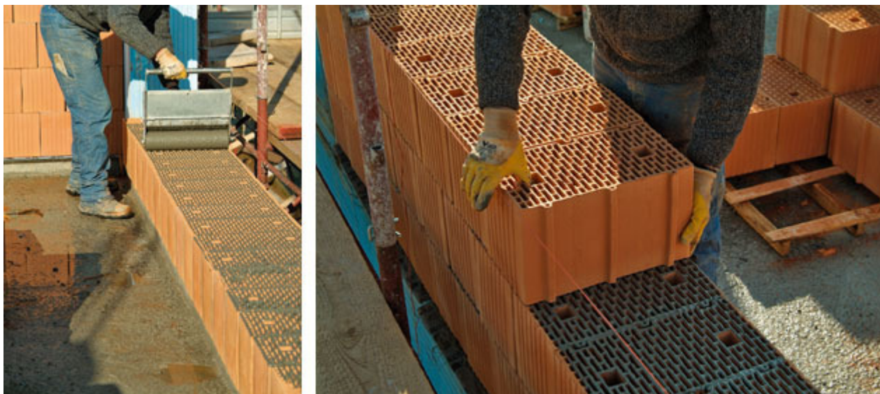
Fig. 4 - Stesura del giunto sottile di malta-colla con rullo stendigiunto (sx), posa del corso di blocchi sulla malta-colla appena stesa (dx).
