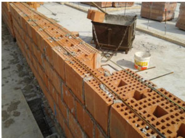
A sinistra, fondazioni a travi rovesce con chiamate delle armature verticali già inglobate nel getto ed impermeabilizzazione. A destra, fasi di realizzazione della muratura armata POROTON®.
