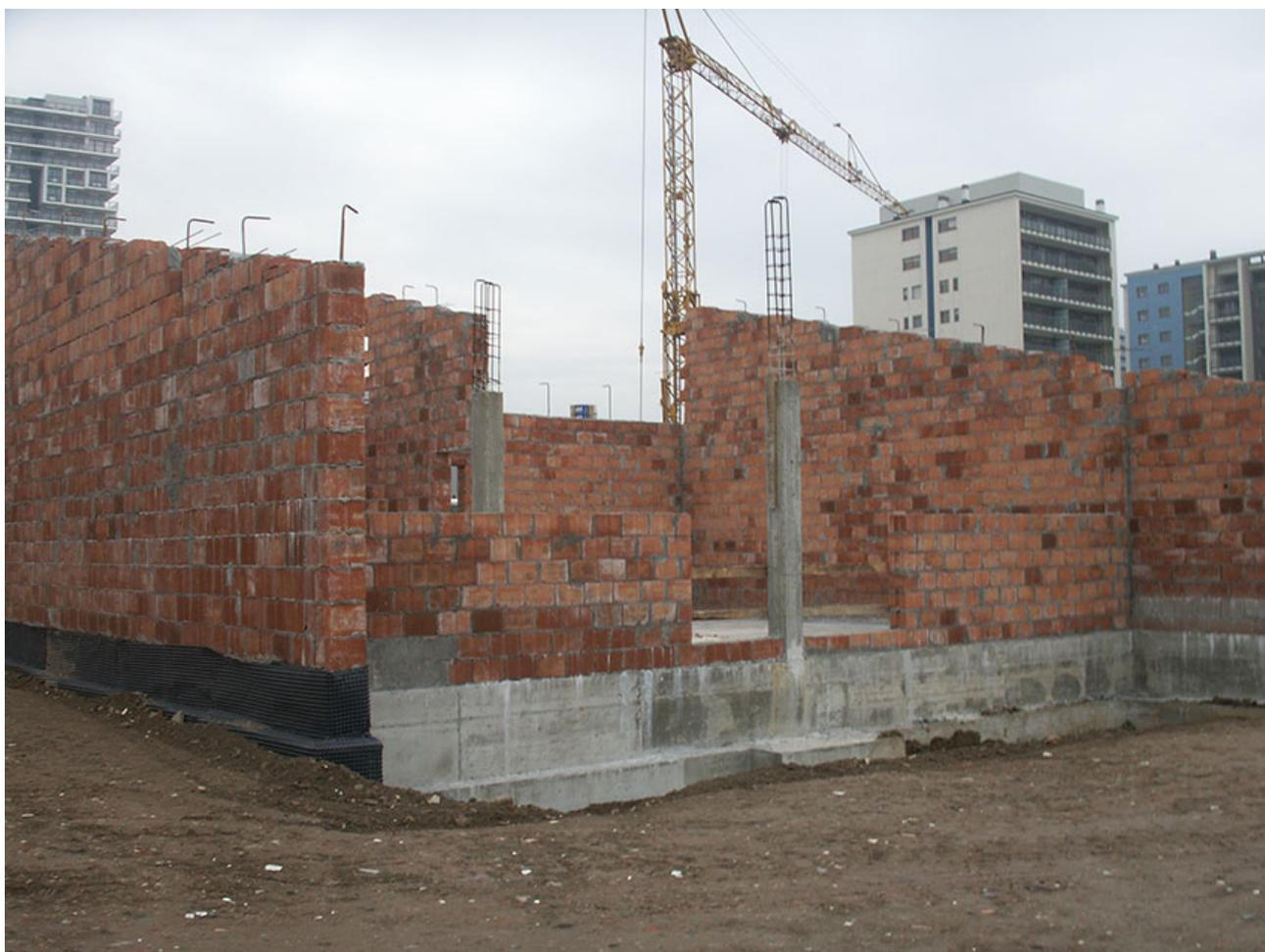
Fig. 2 - Il cantiere con in primo piano le strutture in muratura portante.
