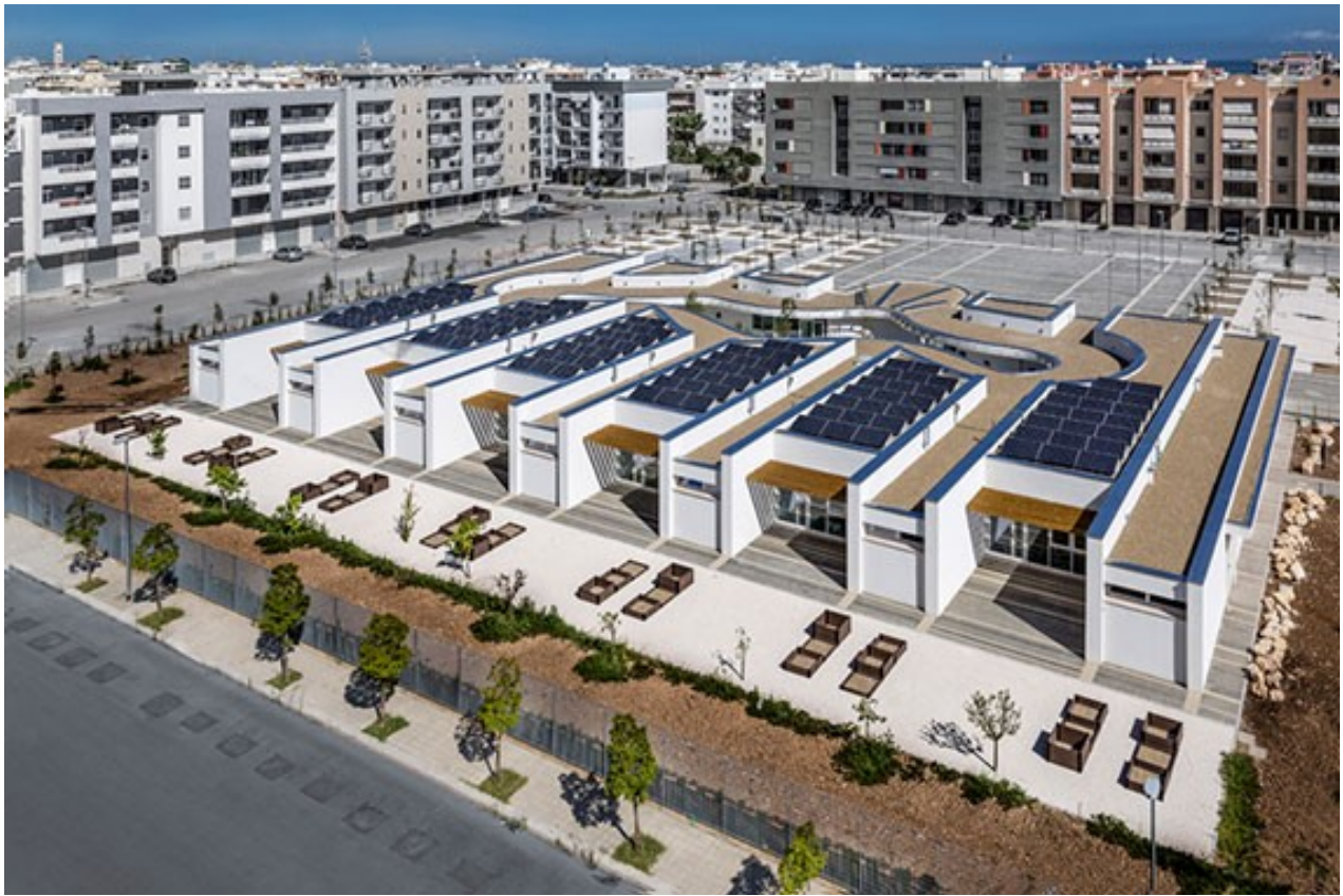
Fig. 6 – Vista aerea della scuola e della piazza al termine dei lavori (copyright Alessandro Peralta).
