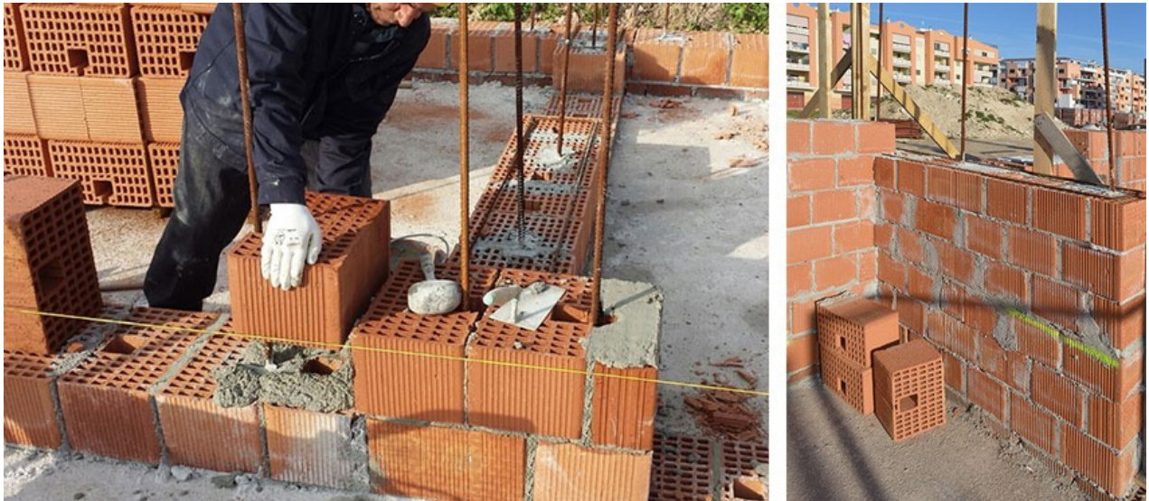
Fig. 3 - Fasi di realizzazione dei setti portanti in muratura armata POROTON® (copyright Luca Peralta).
