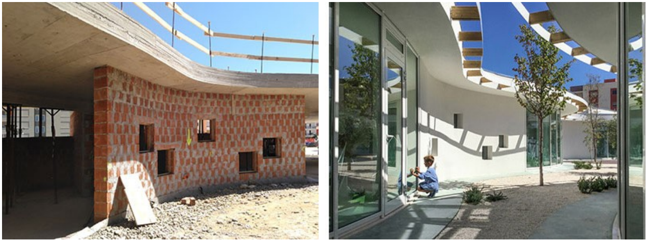
Fig. 4 - La sinuosa parete in muratura armata POROTON® del corridoio anulare che si affaccia sulla corte interna: fasi di cantiere (sx, copyright Luca Peralta) ed al termine dei lavori (dx, copyright Alessandro Peralta).
