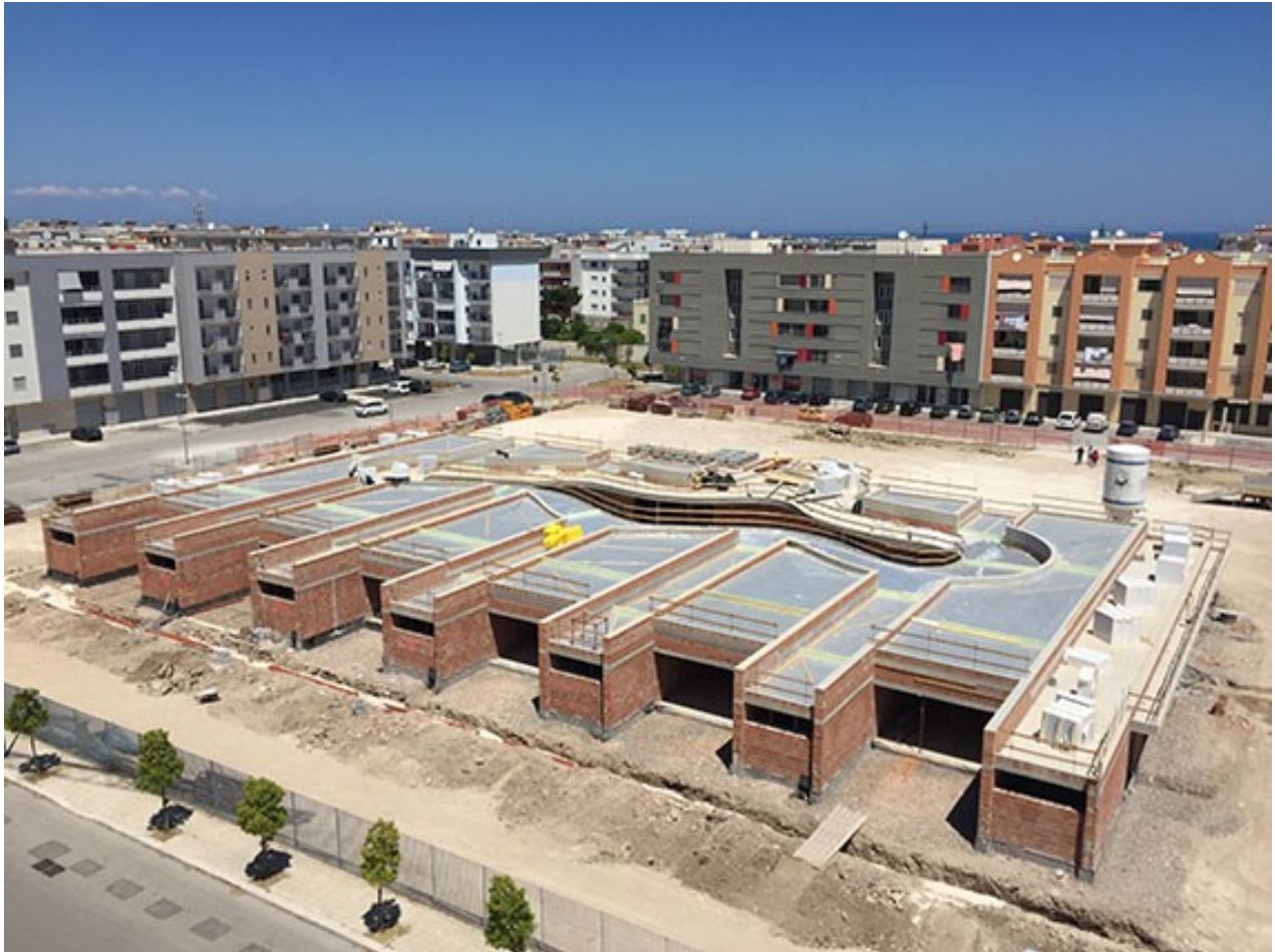
Fig. 5 - Vista aerea della scuola e della piazza in fase di realizzazione (copyright Luca Peralta).
