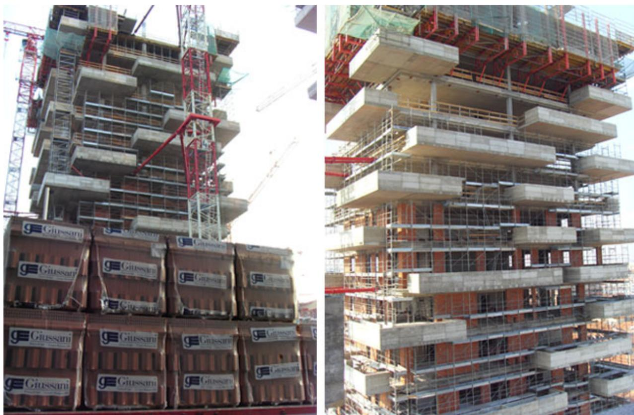
Fig. 5 - Fasi realizzative delle murature POROTON® del Bosco Verticale.
