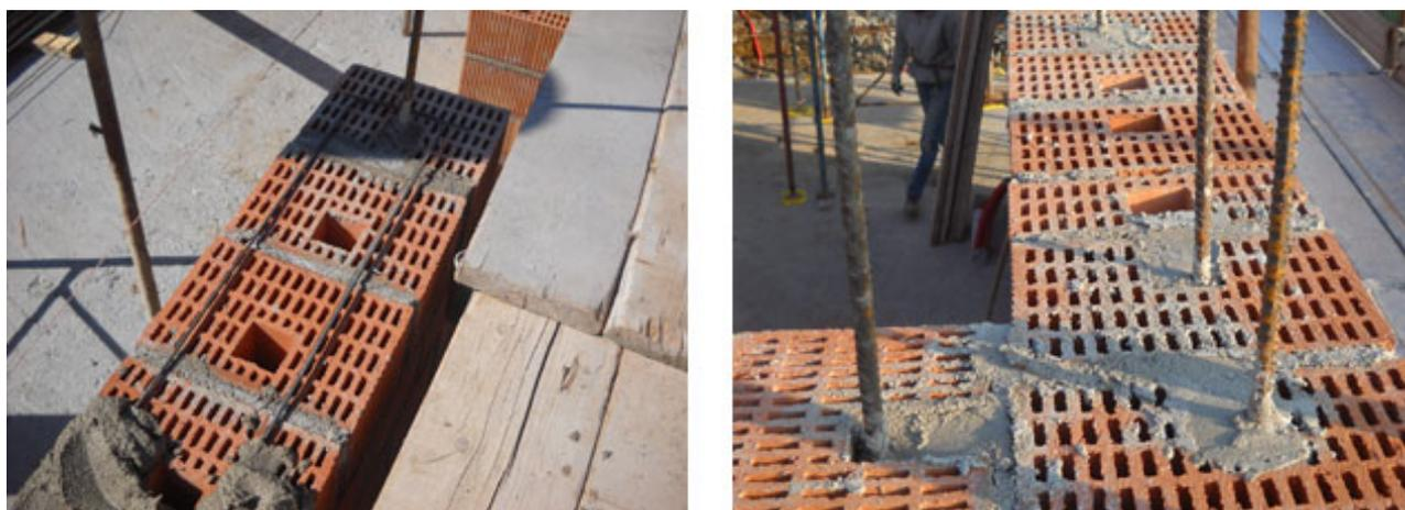
Fig. 2 - Muratura armata POROTON® realizzata a regola d'arte: blocco POROTON® P800 MA Brite con tutti i setti nel piano del muro rettilinei e continui, giunti di malta verticali riempiti, armatura orizzontale disposta nel giunto di malta e armatura verticale negli appositi vani dei blocchi riempiti di malta.
