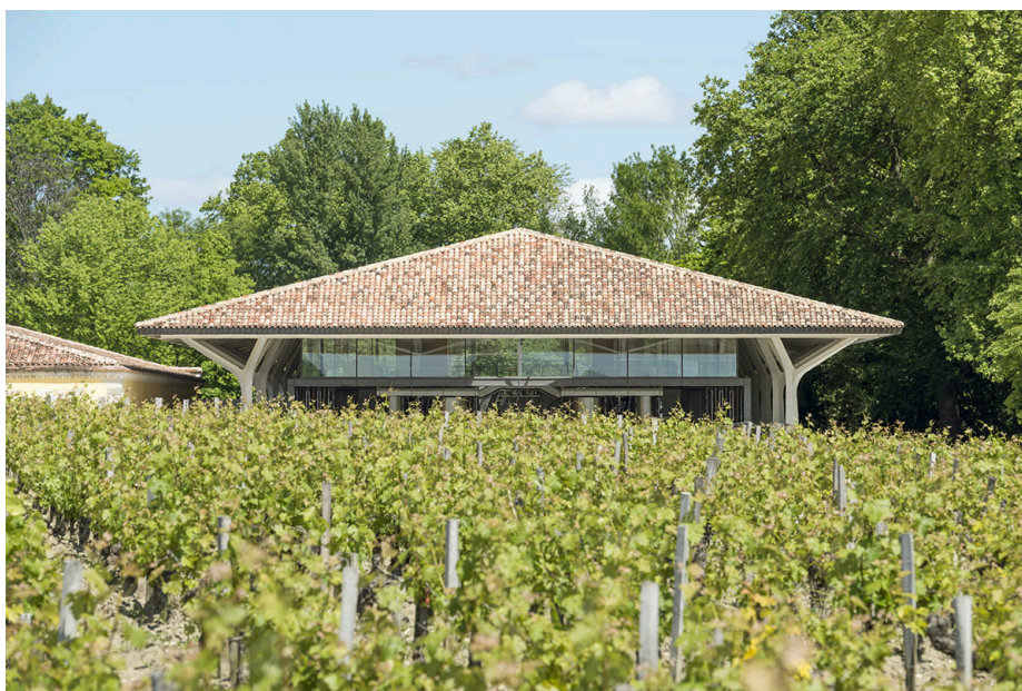
Fig. 2 – Padiglione a Chateau Margaux, Foster+Partners: esempio di progettazione green (CiL 168 – @Nigel Young).
