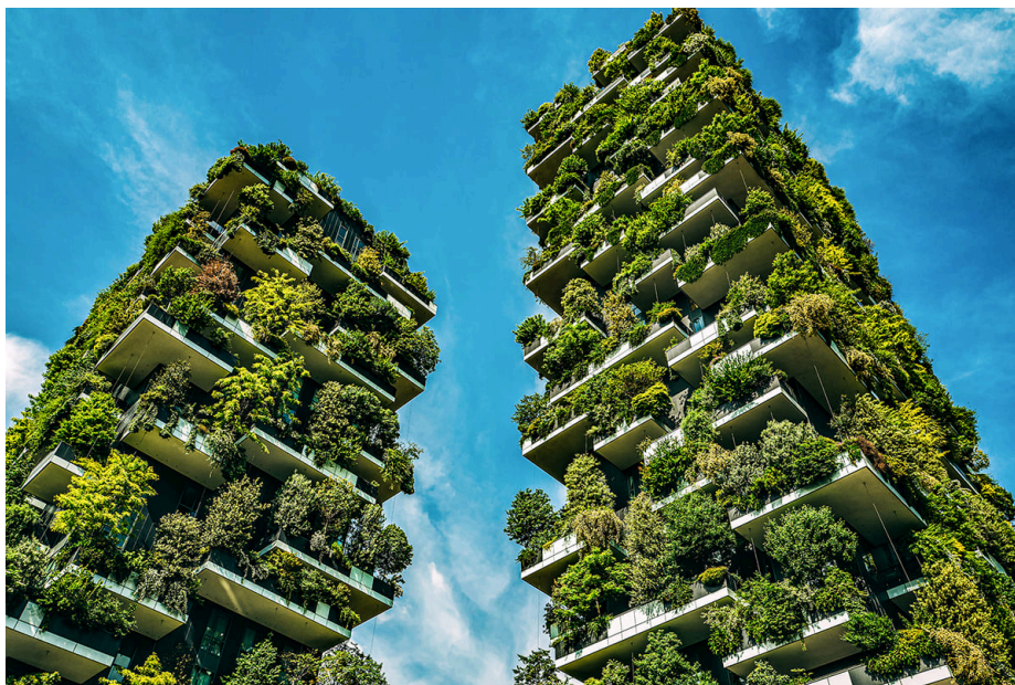
Fig. 1 – Bosco Verticale, Boeri Architetti + Barreca + La Varra: nuovo standard per edifici residenziali sostenibili.
