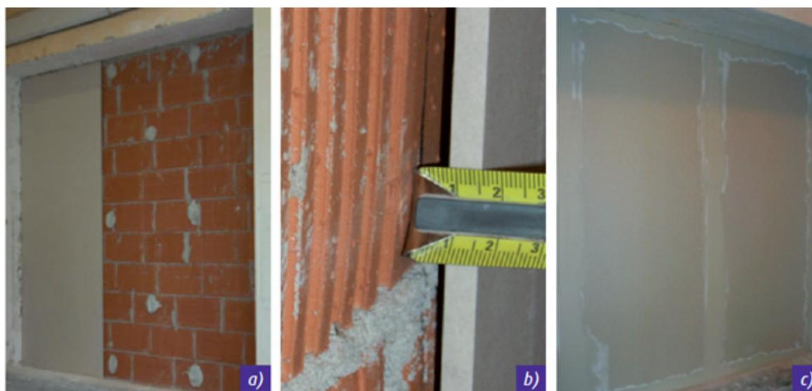
Fig. 1 – Esempio di montaggio del rivestimento realizzato con doppio strato di lastre in cartongesso.
