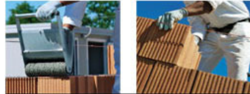
Fasi di posa in opera del sistema PLAN
