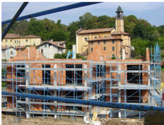
Fig. 7 - Vista del Lotto D in fase di costruzione.
