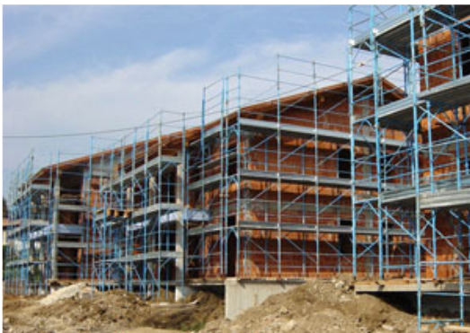
Fig. 3 - Vista del Lotto C in costruzione.
