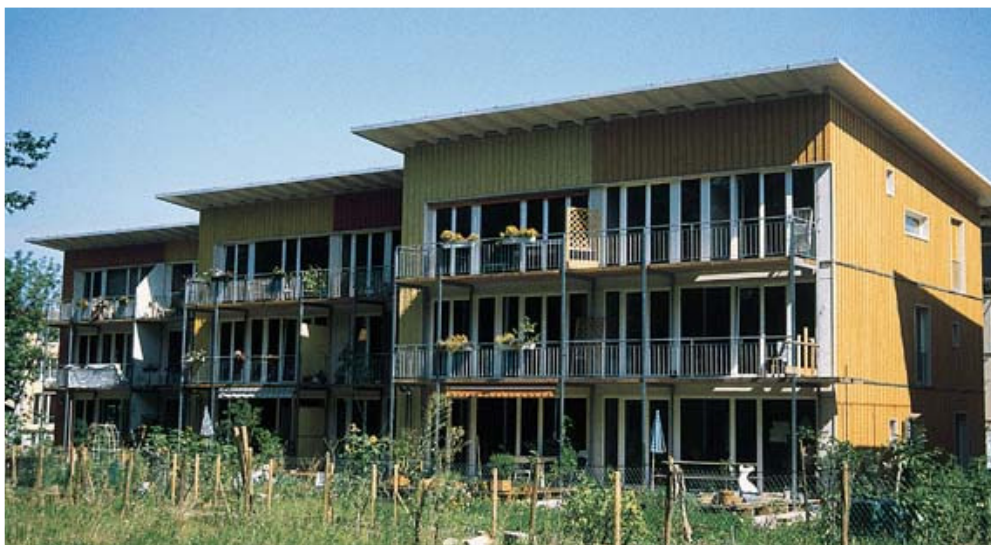
Fig.1 - Un edificio del quartiere Vauban a Friburgo, interamente progettato con l'obiettivo di contenere i consumi energetici. L'edificio in questione fa parte della sezione "Gärtner-Passivhaus", in cui il disegno dei fronti e quello planimetrico sono stati delineati in funzione del percorso solare.
