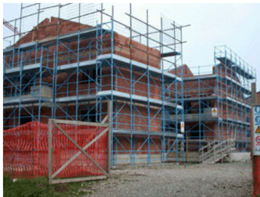
Fig. 8 - Fasi terminali della costruzione di alcuni moduli.
