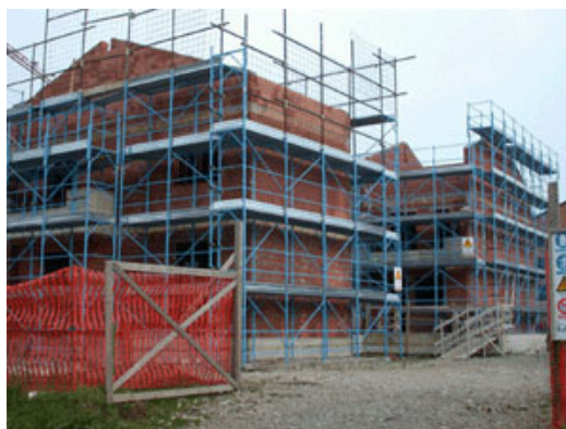
Fig. 8 - Fasi terminali della costruzione di alcuni moduli.
