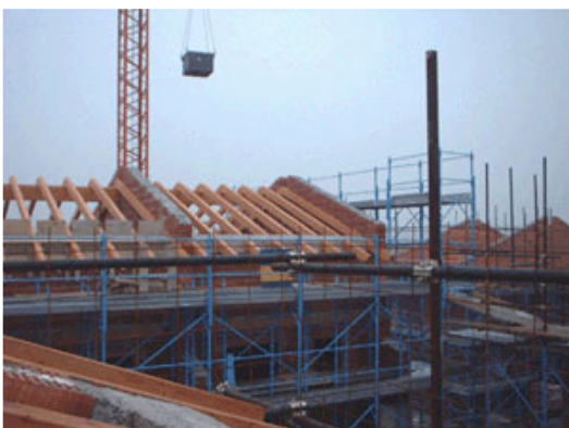
Fig. 9 - Posa della copertura in legno lamellare.
