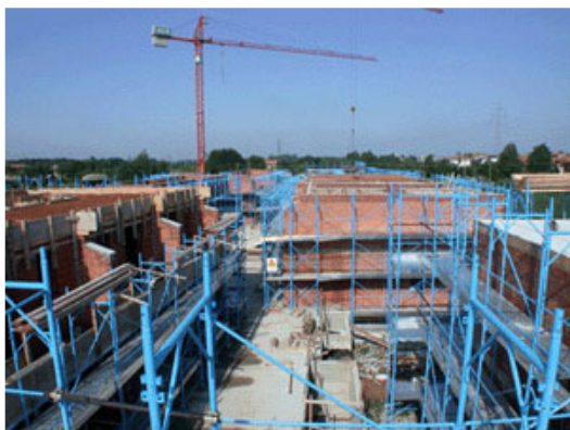
Fig. 7 - Vista d'insieme delle costruzioni all'ultimo impalcato.
