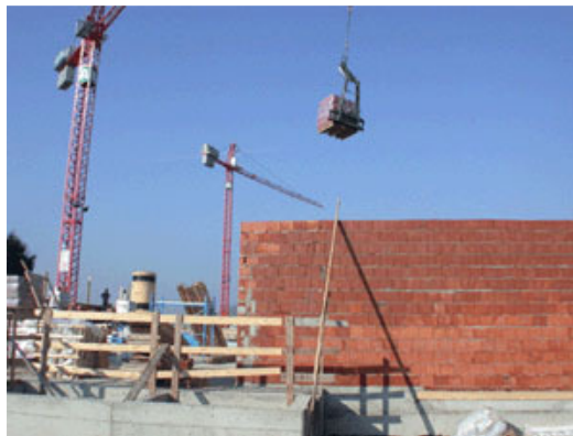
Fig. 6 - Fasi di lavorazione - Primo piano fuori terra: pareti in POROTON®.
