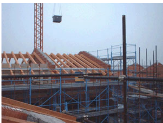
Fig. 9 - Posa della copertura in legno lamellare.
