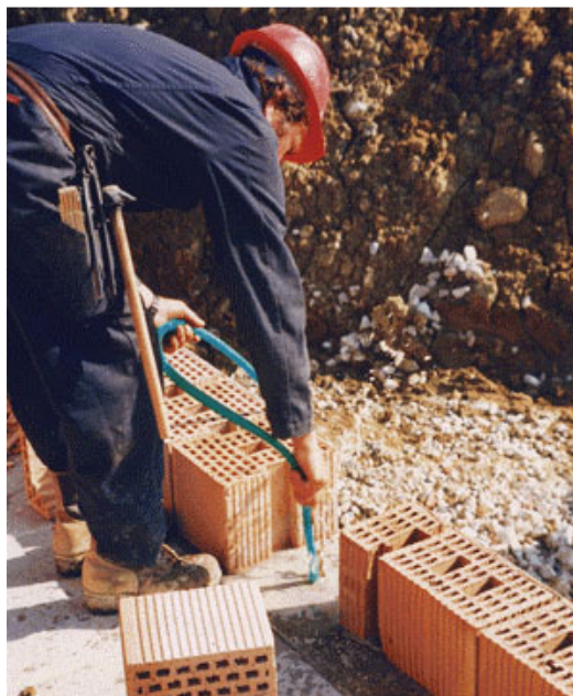
Fig. 5 - Impiego di una miscela (resina epossidica) per l'ancoraggio delle barre in fondazione.
