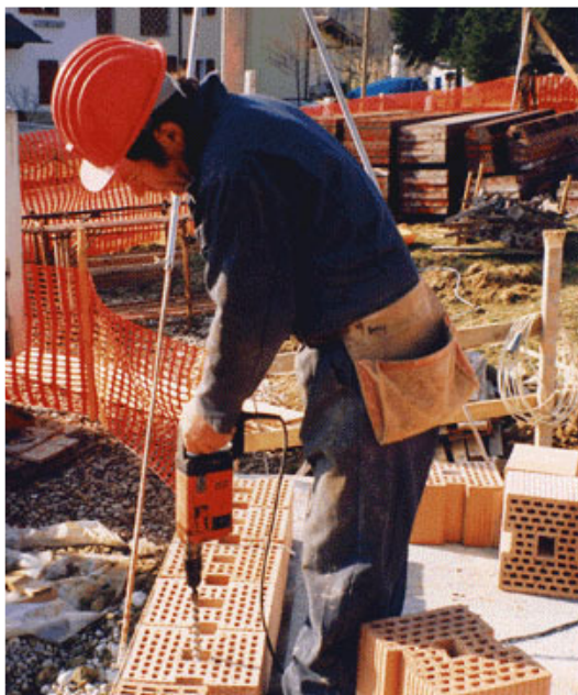
Fig. 4 - Disposizione del primo corso di blocchi "a secco" ed individuazione della posizione delle armature verticali.
