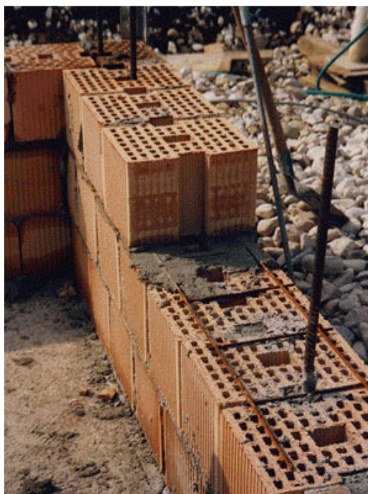
Fig. 9 - Muratura armata in fase di costruzione.
