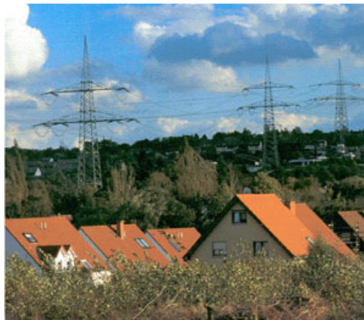
Fig. 4 – Le costruzioni realizzate in prossimità di linee di alta tensione presentano numerosi rischi per la salute degli occupanti.
