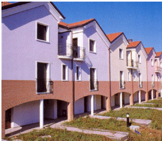
Fig. 3 – Edifici realizzati in edilizia sovvenzionata dal Settore Edilizia Residenziale del Comune di Padova in via Pinelli.
