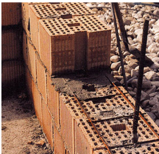
Fig. 1 - Dettaglio di muratura armata.
