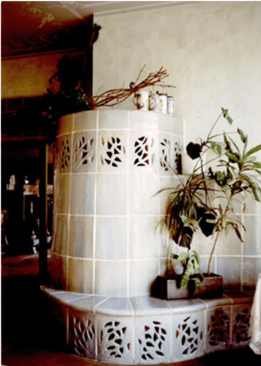
Fig. 2 - La stufa in maiolica (Kachelofen) è un sistema di riscaldamento molto interessante dal punto di vista estetico, che richiede in genere un bel po' di spazio a disposizione. La superficie ceramica si scalda non solo per effetto della combustione della legna, ma anche grazie ad un percorso dei "giri" di fumo studiato in modo da massimizzare la cessione di calore di questi ultimi al refrattario.
