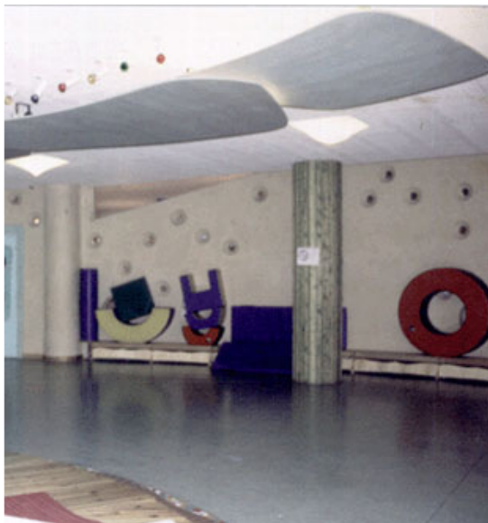
Figg. 3, 4 - Il riscaldamento a battiscopa può essere, come nel caso della scuola materna di Maslianico (CO), ricoperto da un carter in legno disegnato ad hoc e rifinito con finiture naturali. Si veda dal particolare come la fascia retrostante al corpo scaldante sia stata isolata con una striscia di sughero naturale.
