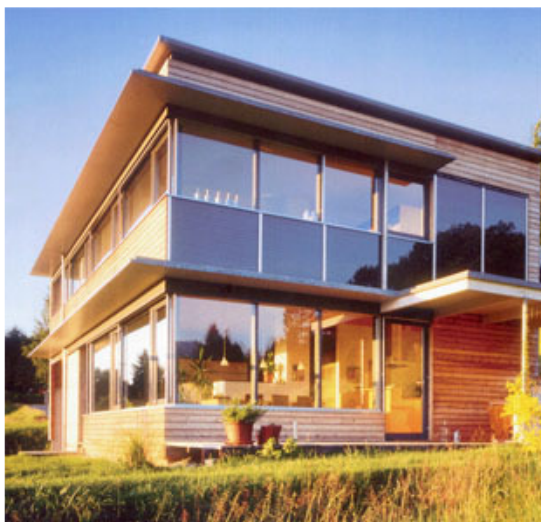
Fig. 1 - Edificio residenziale in Vorarlberg, in cui è presente un elevato livello di integrazione tra edificio ed impianti (una parte della parete esterna è formata da pannelli solari termici), che gli conferiscono un'estetica particolare).
