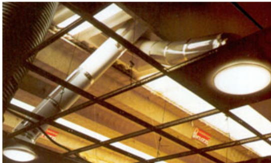
Fig. 3 - La luce naturale può essere anche captata da particolari lucernari che, attraverso una serie di canali riflettenti, la convogliano anche in luoghi non direttamente comunicanti con l'esterno.
