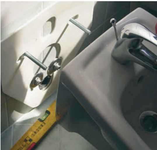
Fig. 6 - Posa del sanitario con elemento separatore.
