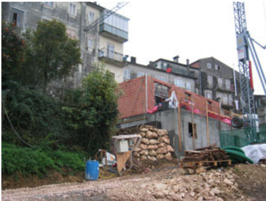
Fig. 3 - Fase di cantiere.
