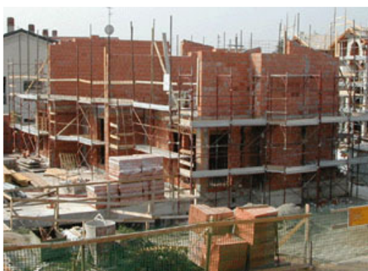
Fig. 5 - Vista delle strutture del piano primo.
