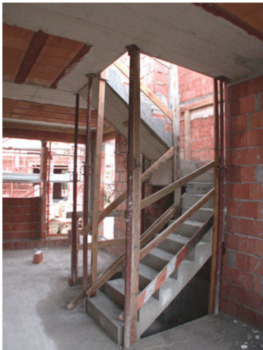
Fig. 8 - Particolare murature e scala interna.
