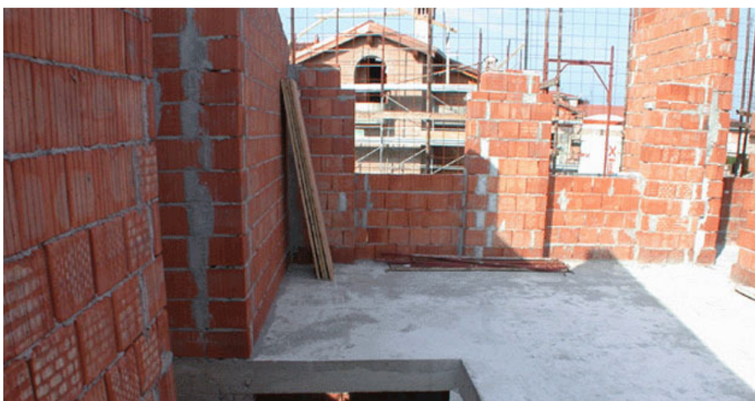
Fig. 7 - Particolare murature e sbarco scala interna.
